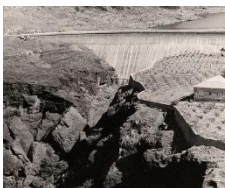
Los Peñones con el muro de la presa al fondo. CEDIDA
