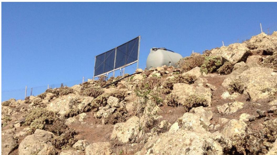
El funcionamiento de los captadores de niebla es simple. Se colocan unas mallas sobre una estructura vertical en las zonas altas de las montañas, con el fin de interceptar la niebla o la humedad que atraviesa las mismas por la acción del viento, formando gotas de agua que caen por la gravedad a unos canales hasta un depósito de almacenamiento.
