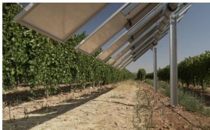
Los viñedos que González Byass y Grupo Emperador tienen en Guadamur (Toledo) se beneficiarán de la primera planta agrovoltaica inteligente instalada en España. De ello se ha encargado la empresa Iberdrola. Esta innovadora instalación permite adaptar la disposición de las placas solares a las necesidades de las viñas para regular mediante la sombra de los paneles la incidencia del sol y la temperatura.
