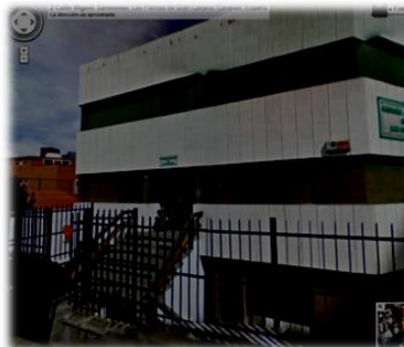
Exterior de la oficina
